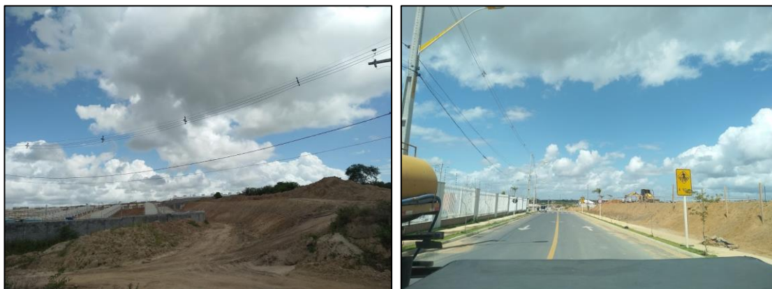
Figura 11 - Condomínio em construção no Registro
