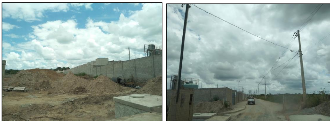
Figura 13 - Obras de condomínios no bairro Papagaio
