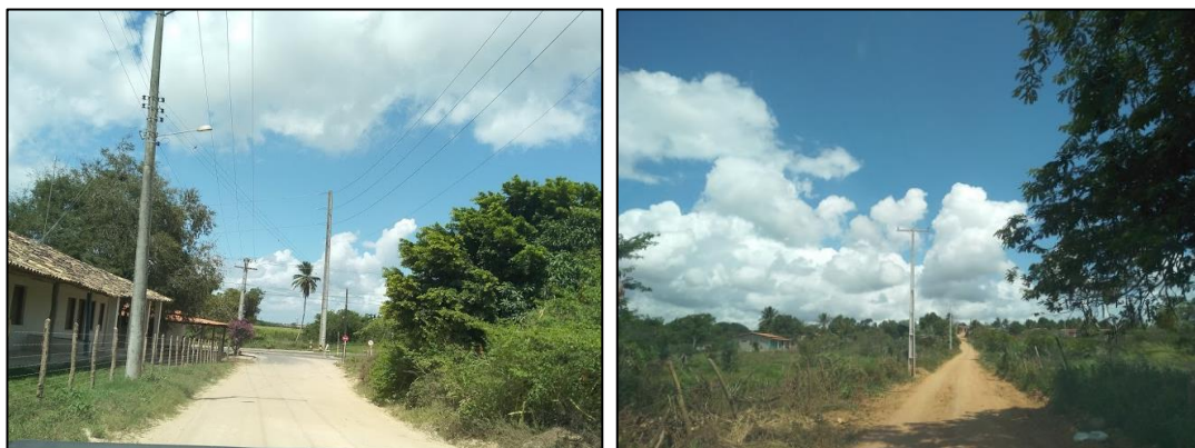
Figura 12 - Estrada do Registro
